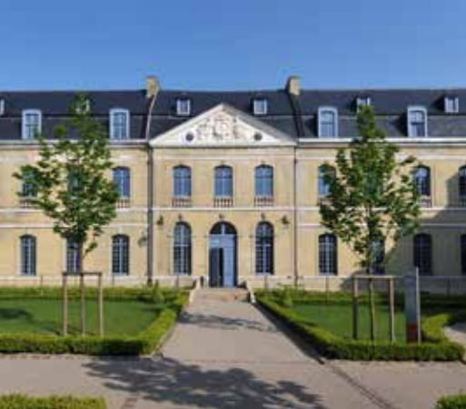
L'ancien hôpital général fondé en 1702 par l'évêque Louis-Alphonse de Valbelle accueille le centre administratif de Saint-Omer depuis 2007.
