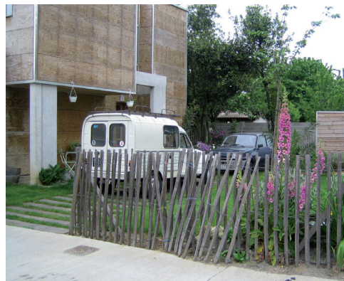
Stationnement des véhicules en file indienne sur l'espace privé afin de minimiser leur impact
