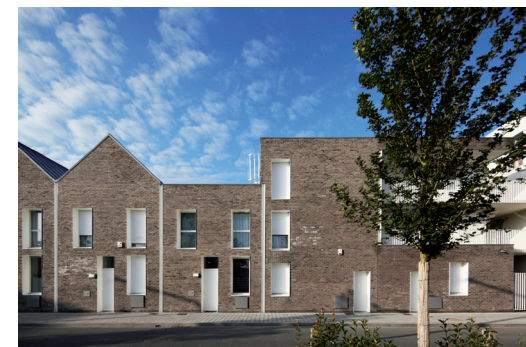
Maisons de ville en briques unitaires avec toitures variées et marquage des limites entre les maisons par une gouttière encastree
