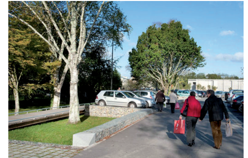
Tamponnement des eaux pluviales dans des espaces plantés légèrement décaissés
