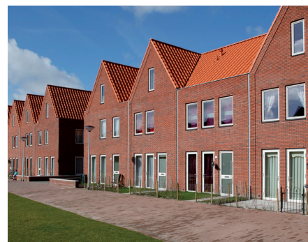
Maisons de ville en briques unitaires avec toitures variées et marquage des limites entre les maisons par une gouttière encastree
