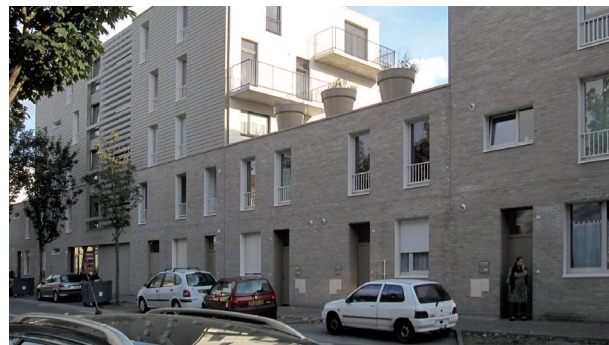
Collectif superposé à des maisons de ville, façades sur rue en briques.
