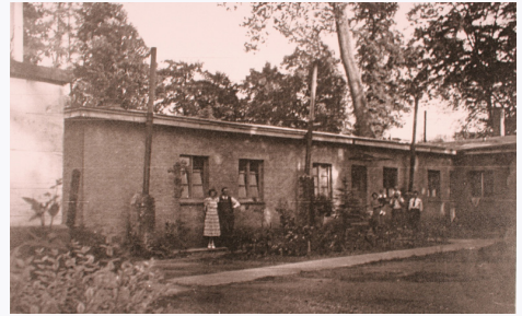
Bâtiments des dessinateurs transformés en habitation après la Seconde Guerre mondiale.
